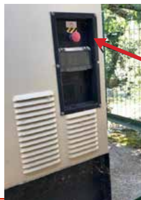
Organe de coupure sur le groupe électrogène
